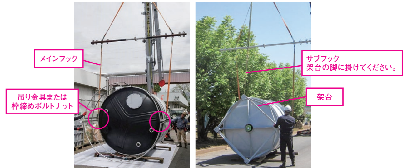
[写真-25、26] 左：天板側、右：架台側から見た吊り具の掛け方(イメージ)
